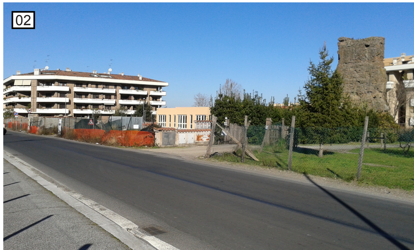
Via del Casale Ferranti all'intersezione con l'antica Via latina, visibile i resti del sepolcro in laterizio sullo sfondo Il nuovo centro polifunzionale in fase di realizzazione - l'area appartiene alla sottozona TOc n. 50 del PTP 15/12
