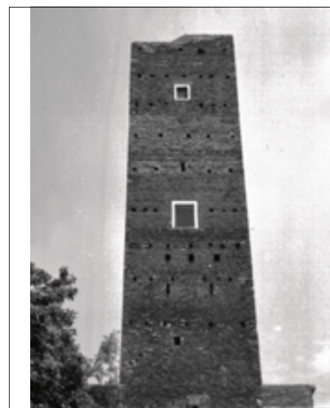
TR Torre delle Cornacchie
