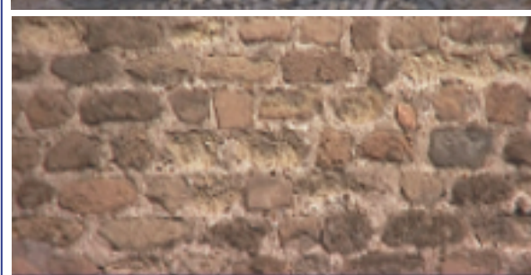
Muratura di pezzame di tufo Muratura mista di pezzame di tufo e tegolozza
