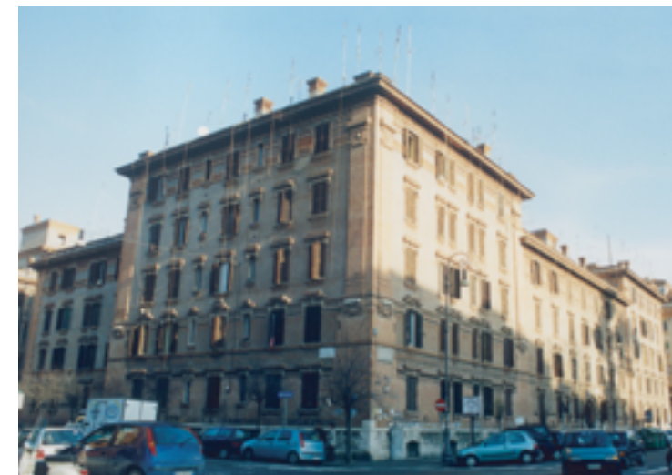
Edificio in linea aggregato a blocco
