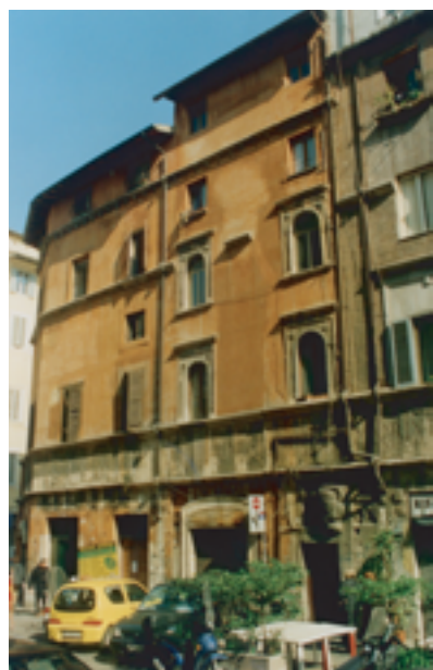
Casa a schiera plurifamiliarizzata
