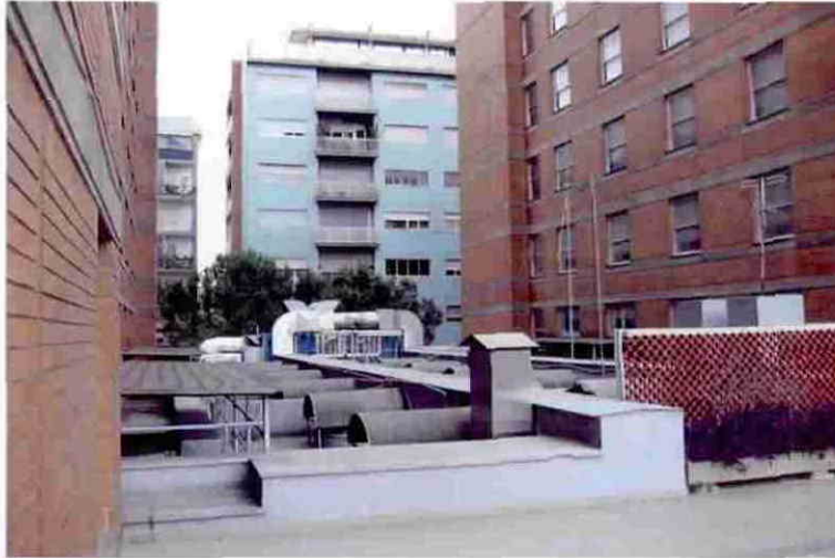
10. spazio compreso tra i due corpi edilizi (terrazza piano secondo)
