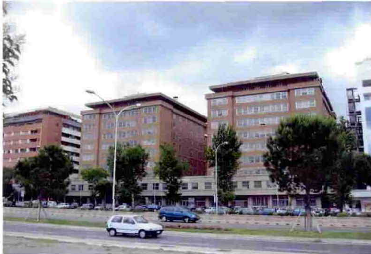
2. vista da via cristoforo colombo (prospetto A)
