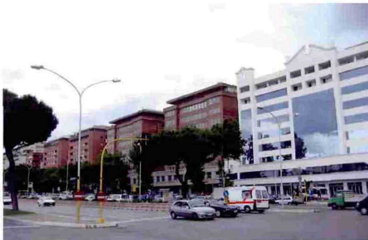
3. vista da via cristoforo colombo (prospetto A)
