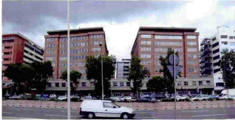
1. vista da via cristoforo colombo (prospetto A)
