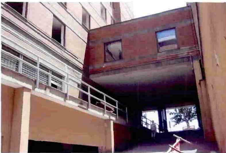
6. particolare rampa di accesso alle autorimesse (lato ovest)
