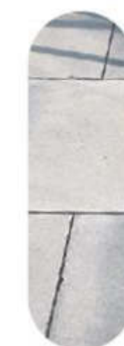
Blocchi di calcestruzzo
