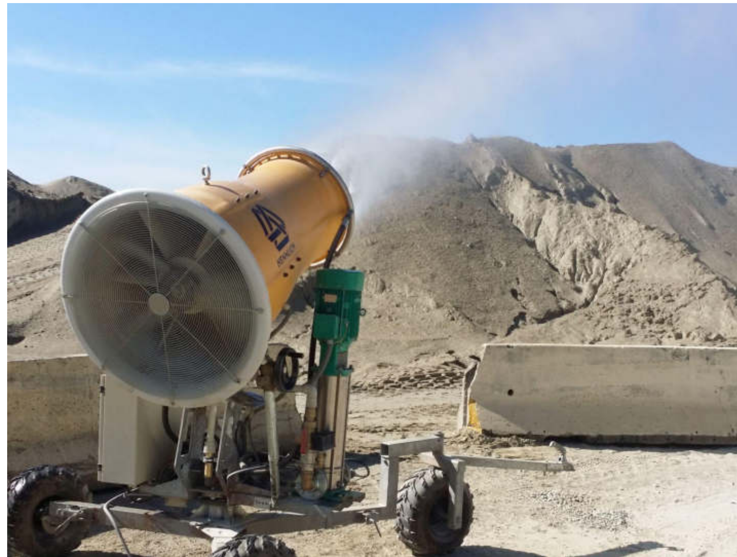
MISURE DI PROTEZIONE ATTIVA (cannoni ad acqua nebulizzata per abbattere le polveri durante la fase di scavo)
