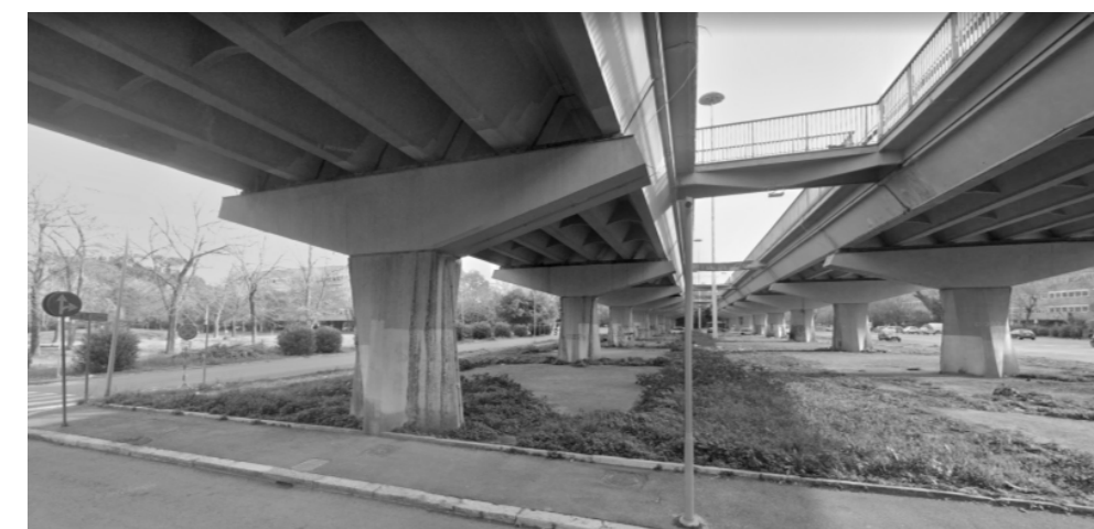
Gli spazi aperti sottostanti il viadotto di Corso Francia
