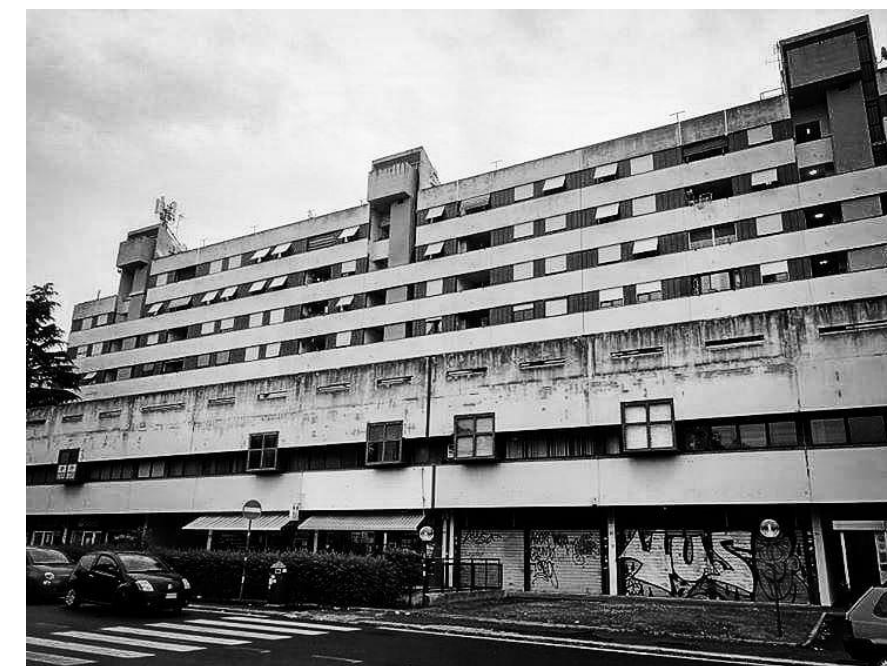
Gli edifici in linea del "serpentone"
