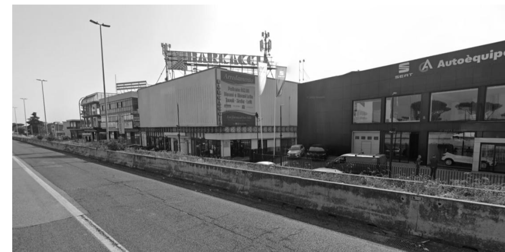
Le strutture commerciali che si affacciano sul G.R.A.
