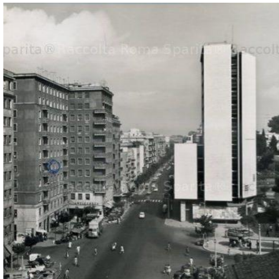
La grande mole del serbatoio dell'acqua definisce lo spazio di piazza Rosolino Pilo
