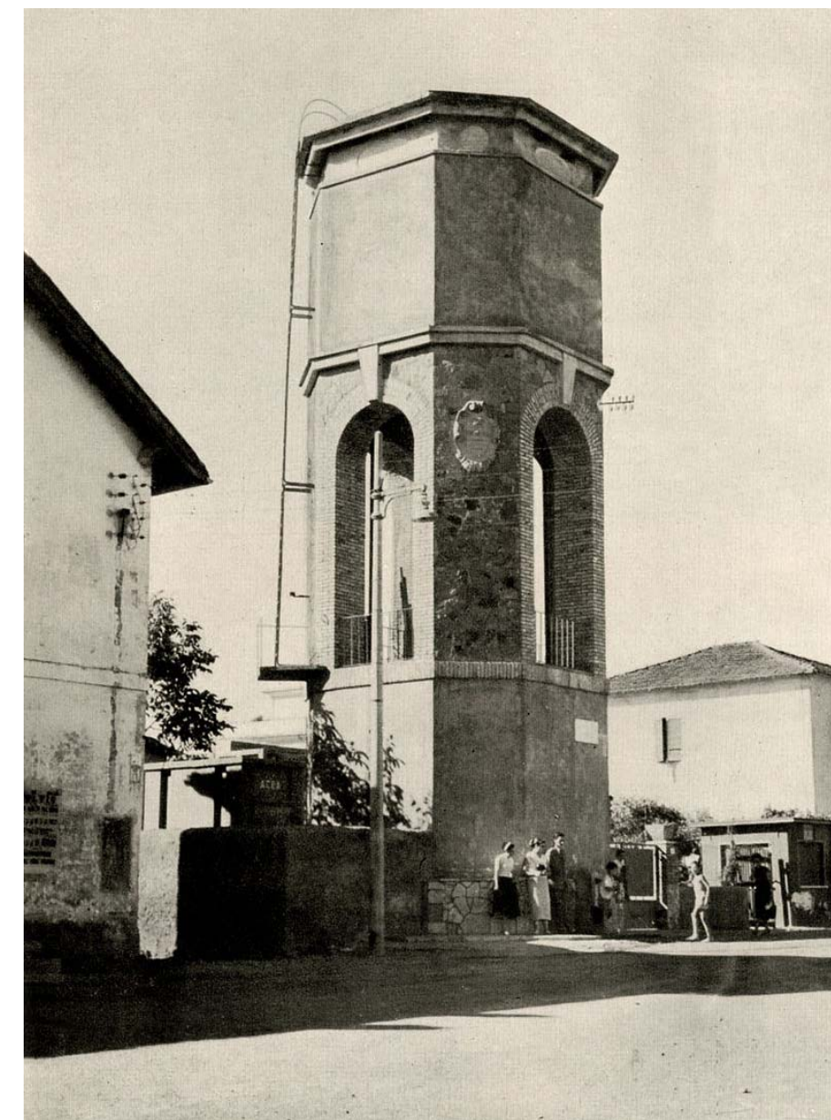
Il serbatoio idrico di via Cornelia negli anni '50
