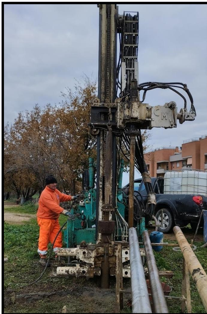
*Figura 6.2 – Esecuzione sondaggio a carotaggio continuo SI. a) Esecuzione del Sondaggio Geognostico; b) Esecuzione delle prove SPT.*
