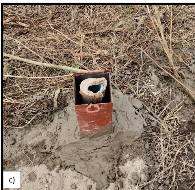
*Figura 6.5 – Esecuzione sondaggio a carotaggio continuo S2PZ. a) Esecuzione del sondaggio geognostico; b) Esecuzione delle prove SPT; c) ISTALLAZIONE tubo piezometrico.*
