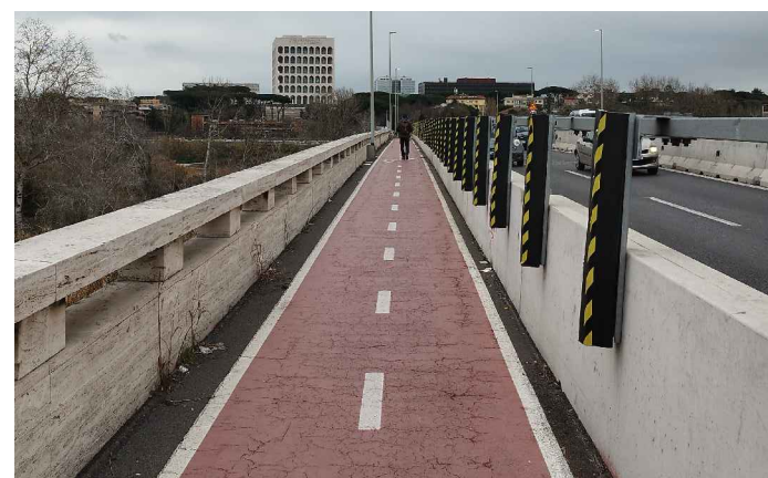
Vista dal viadotto sulla A91 guardando verso l'EUR
