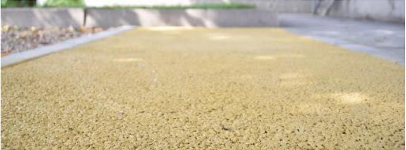
Figura 9 - immagine del calcestruzzo drenante gettato in opera colorato con ossidi di ferro
