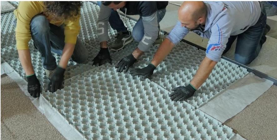
Figura 30 – Immagine della lastra di base sui cui impostare la pavimentazione antitrauma. La lastra è allettata su sottofondo drenante in ghiaia e poi, una volta applicati i pannelli secondo le quote del progetto, le cellule esagonali del pannello vengono intasate di granuli di gomma riciclata SBR, a formare un sottofondo - di tipo aperto- di applicazione della gomma colata finale. In questo modo la pavimentazione in gomma colata risulterà drenante e perfettamente reversibile e riciclabile
