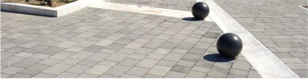
Figura 11 pavimentazione in spessore 8 cm per le aree centrali della piazza. Lo spessore maggiorato garantisce performance migliori in caso di carrabilità occasionale del manufatto
