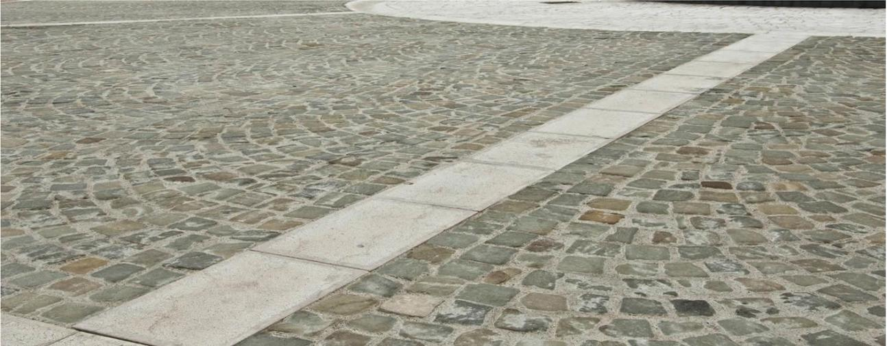
Figura 15 - Le fasce di travertino proposte dal progetto avranno il compito di conferire una profondità prospettica alla piazza un arricchimento, una articolazione spaziale e una nuova scansione ritmica del nuovo manufatto protesa a favorire le relazioni trasversali. Le semplici pavimentazioni in masselli di cemento e in conglomerato drenante troveranno una cornice nobile che le compartimenta e circoscrive
