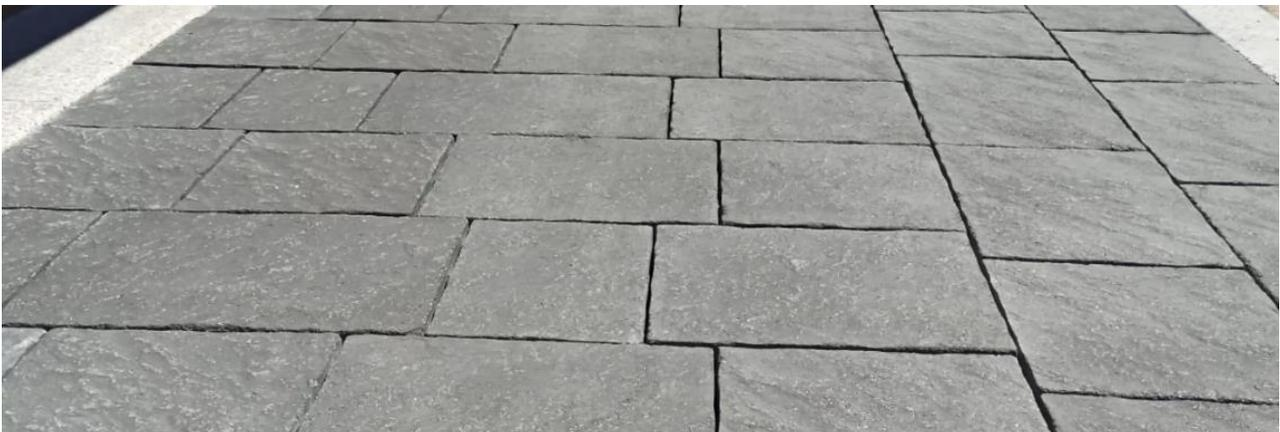
Figura 10 - pavimentazione in spessore 6 cm pedonale per la realizzazione delle aree perimetrali
