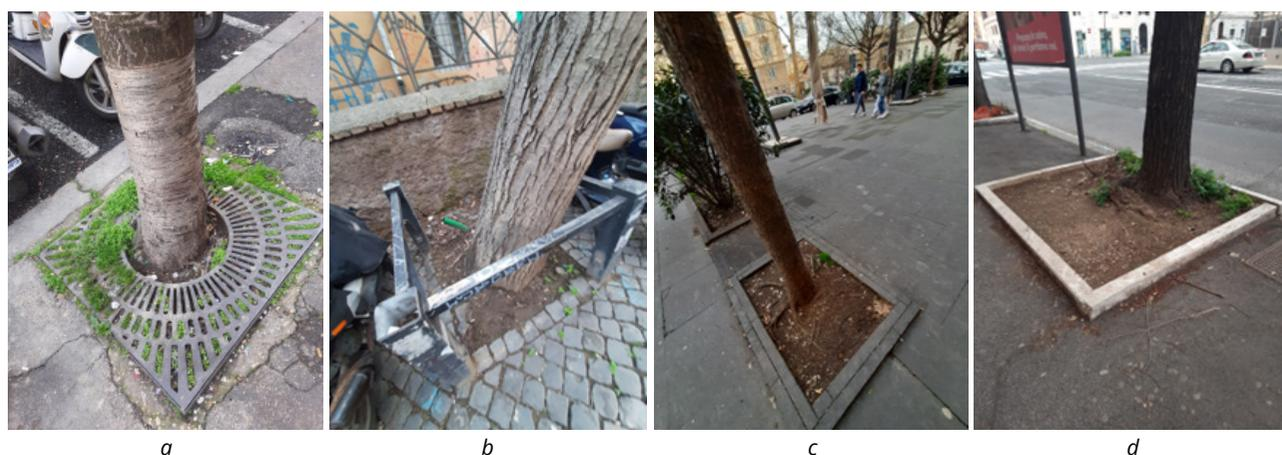
Figura 5.11 – Esempi di formelle in soddisfacente stato di manutenzione (a – griglia metallica per *Prunus*; b – formella con sampietrini e struttura protettiva metallica sui lati per *Juglans*; c – cordoli e pavimentazione di analogo materiale per *Acer*; d – cordoli in travertino per *Ulmus*).
