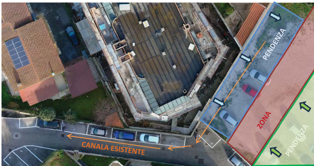
Fig.15 Protezione muro di contenimento
