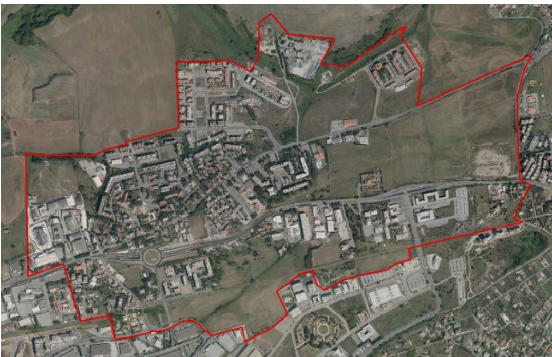
1 | Foto aerea dell’area con individuazione del perimetro di intervento.
