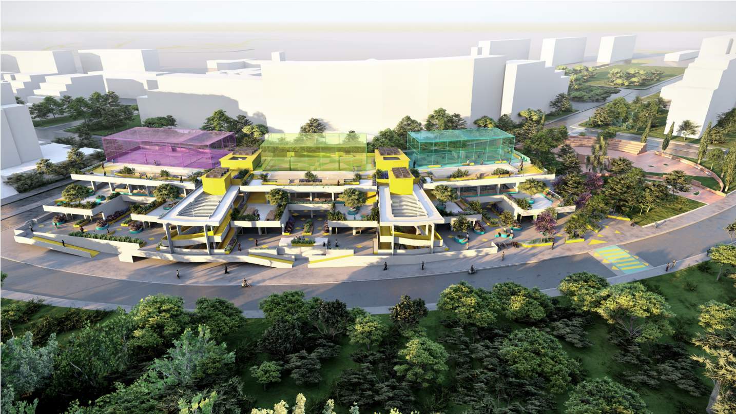
Vista aerea generale
