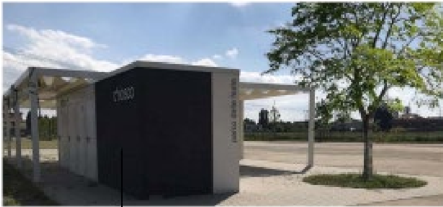
struttura chiosco prefabbricato e servizi igienici in calcestruzzo armato
