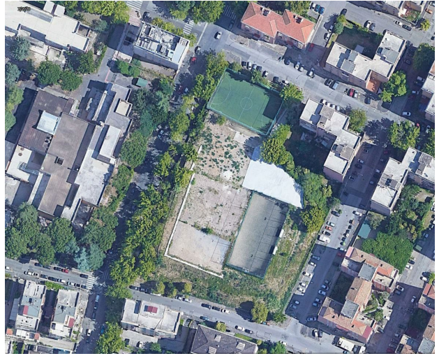
2020 – foto aerea - google earth
