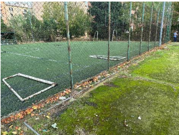
3 campo sportivo in stato di abbandono
