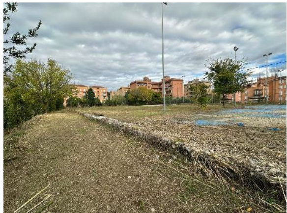
4 area degradata a sud del complesso
