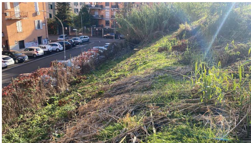
Foto 3 - scarpata via Monte Soprano
