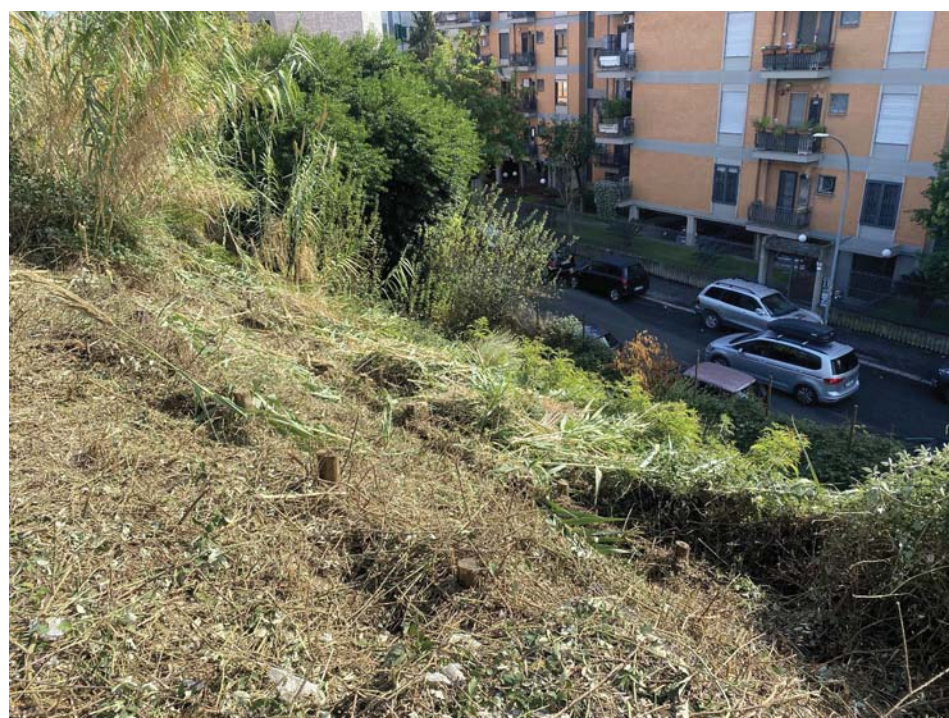
Foto 4 - scarpata via Monte Croce
