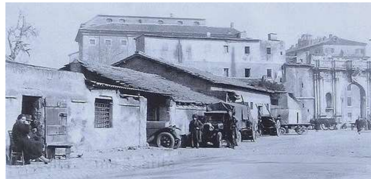
Le prime baracche installate a Via Portuense
