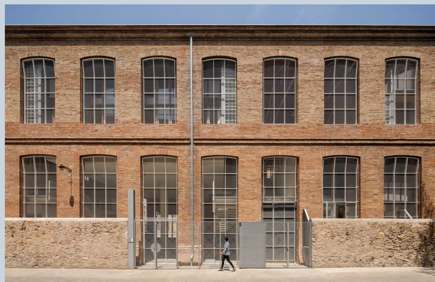
Immagine 1: Facciata dell'edificio residenziale
