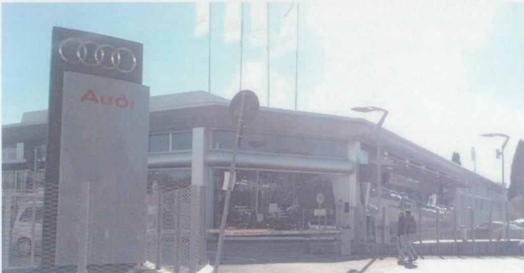
Fig. 13 - Edifici ad uso prevalentemente non residenziale (concessionarie di automobili) lungo via del Casale di Settebagni
