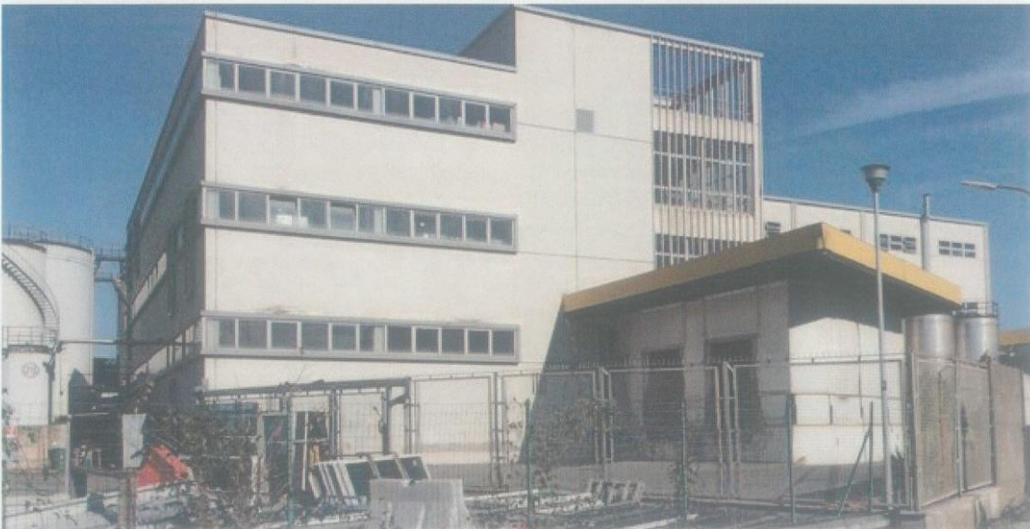
Fig. 11, 12 - Edifici ad uso prevalentemente non residenziale lungo Via Salaria
