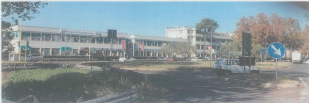
Fig. 14, 15 - Edifici ad uso prevalentemente non residenziale lungo via del Casale di Settebagni
