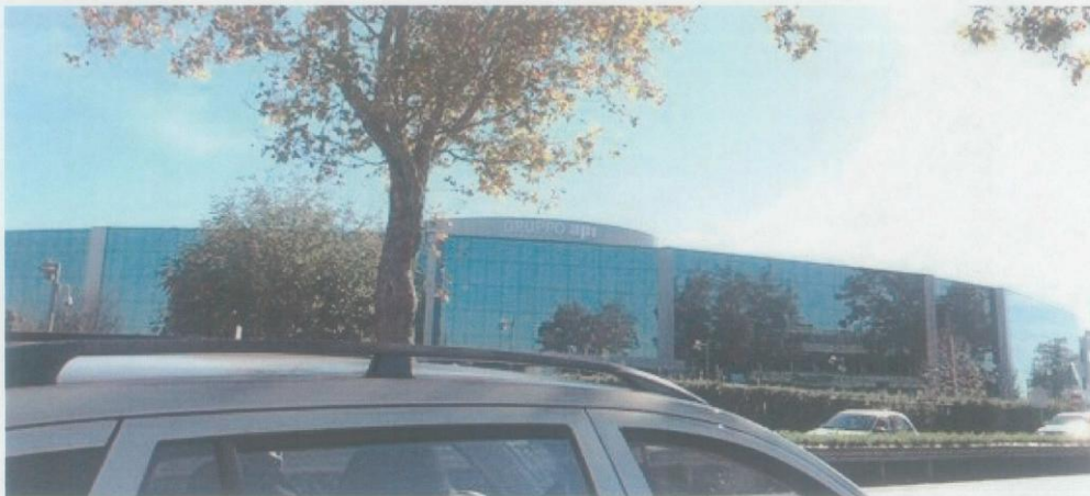
Fig. 10 - Edifici ad uso prevalentemente non residenziale lungo Via Salaria
