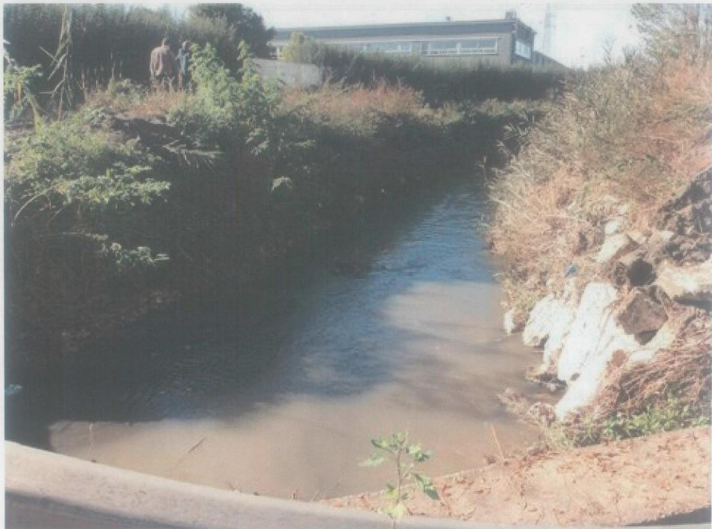
Fig. 4, 5 - Fosso di Settebagni dal ponte di Via Lello Maddaleno
