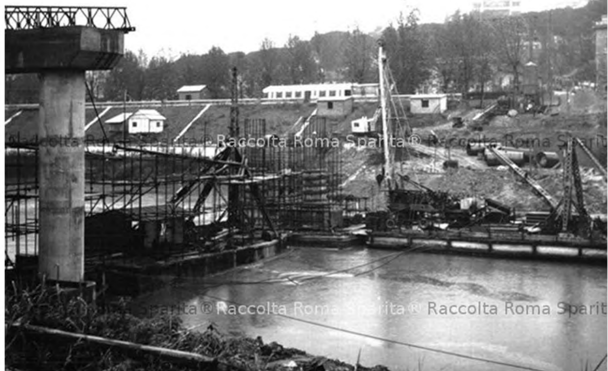
Ponte Bailey in costruzione Fonte: www.archivio.unita.it - www.romasparita.eu
