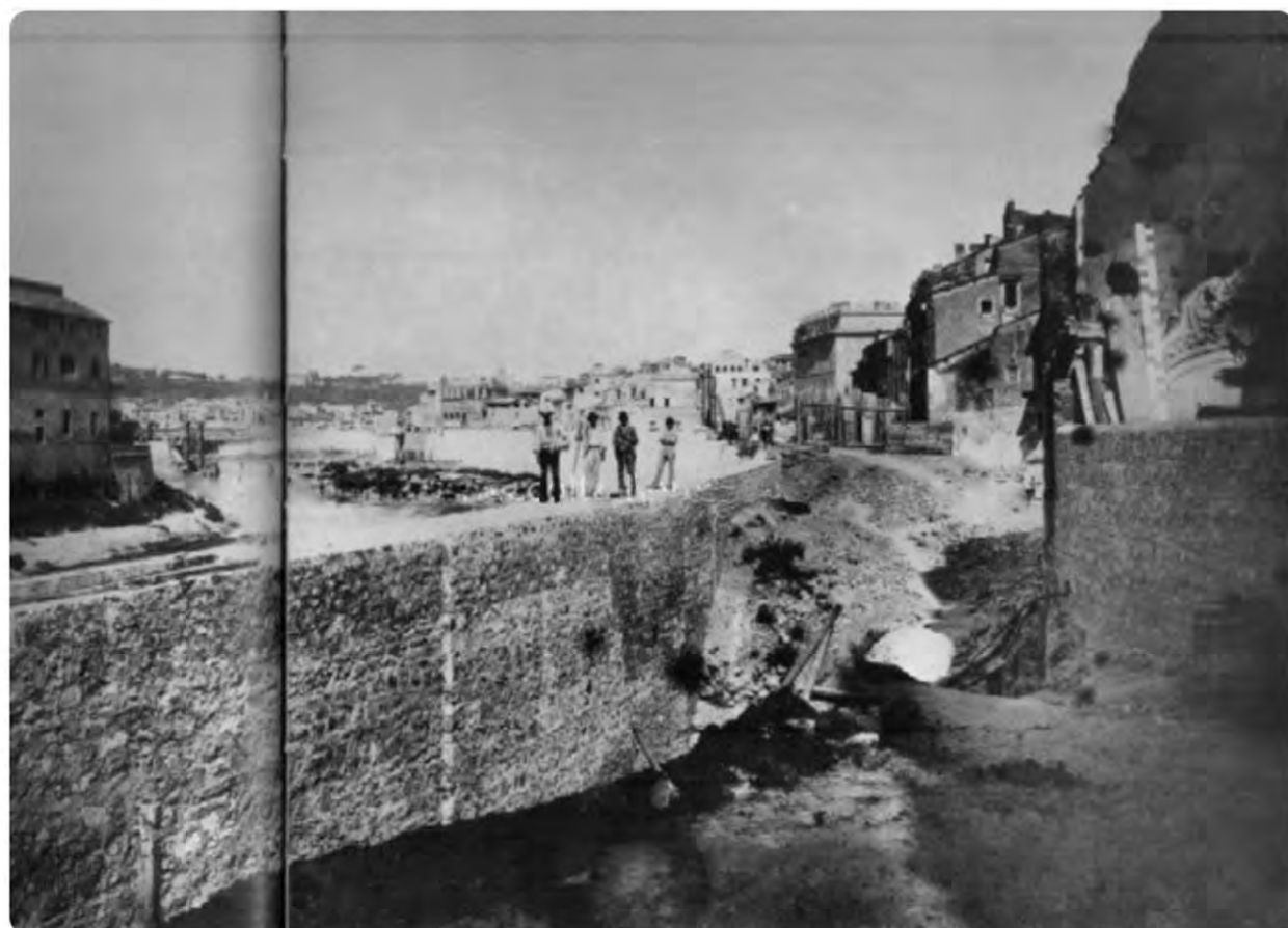
Lungotevere, costruzione dei muraglioni nei pressi dell'isola Tiberina, autore sconosciuto
