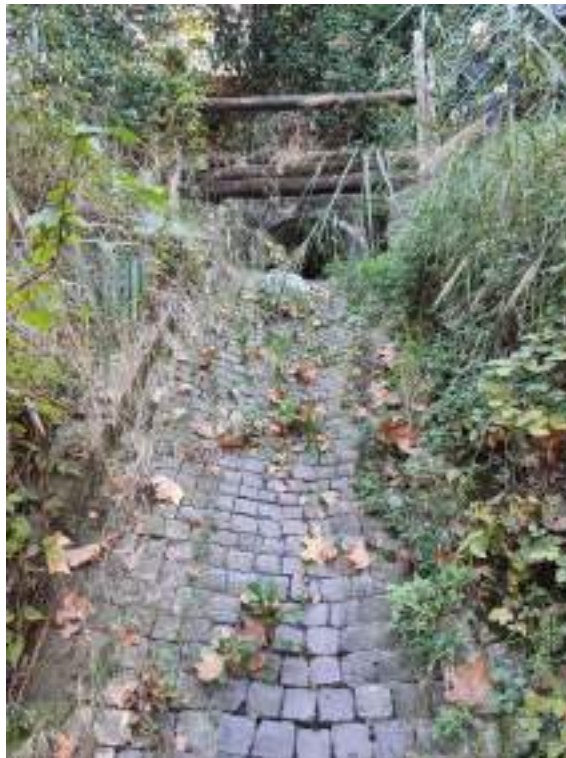
Figura 2: Sbocco del collettore di acque chiare.
