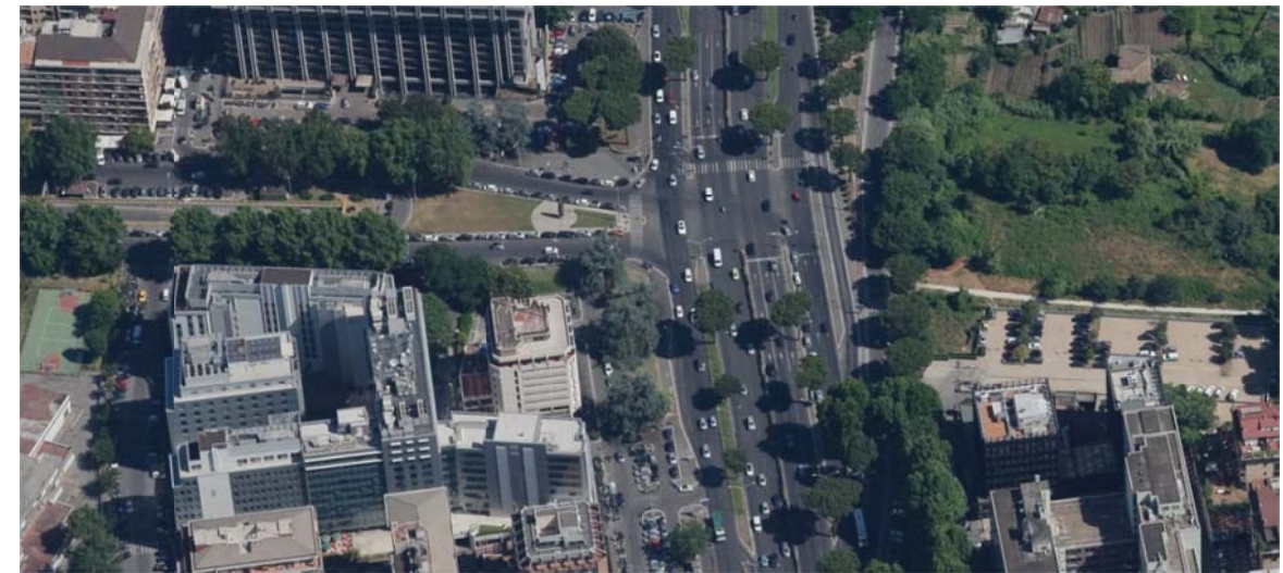
Il tratto terminale della circ.ne Ostiense e l'immissione su via Cristoforo Colombo
