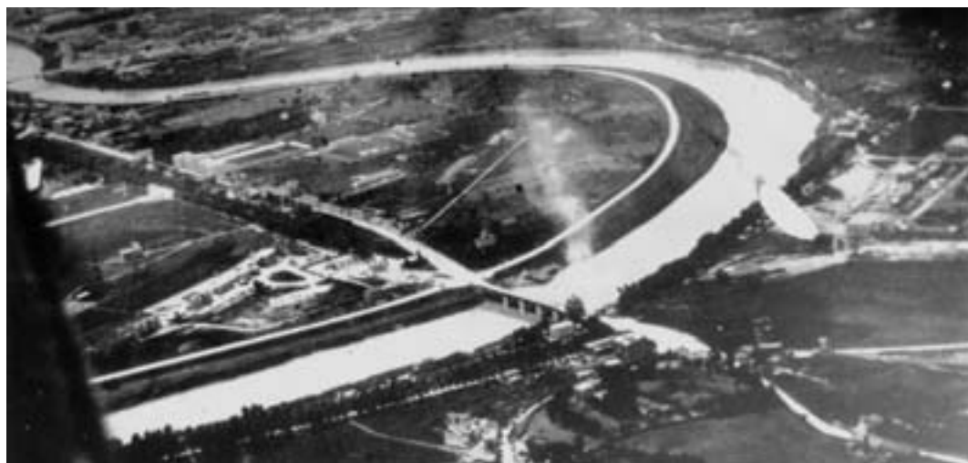
4. Foto aerea dell'ansa del Tevere tagliata da via Flaminia. In primo piano ponte Milvio, sulla destra gli impianti del Poligono di Tiro, al centro gli stabilimenti della Società Automobili "Roma" su via Flaminia e via dei Settanta, ora Guido Reni, e della Società per l'Acciaio. Dall'altro lato del fiume i padiglioni dell'Esposizione Internazionale del 1911.
