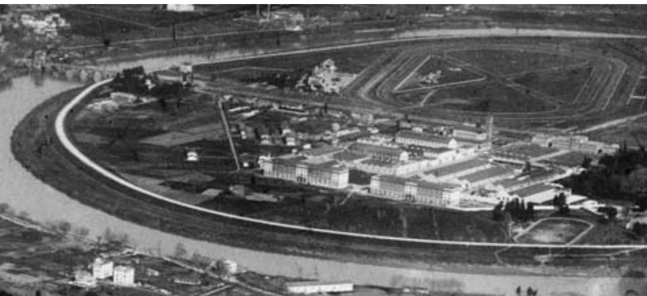
5. Foto aerea della Reale Fabbrica d'Armi con le caserme di servizio.
