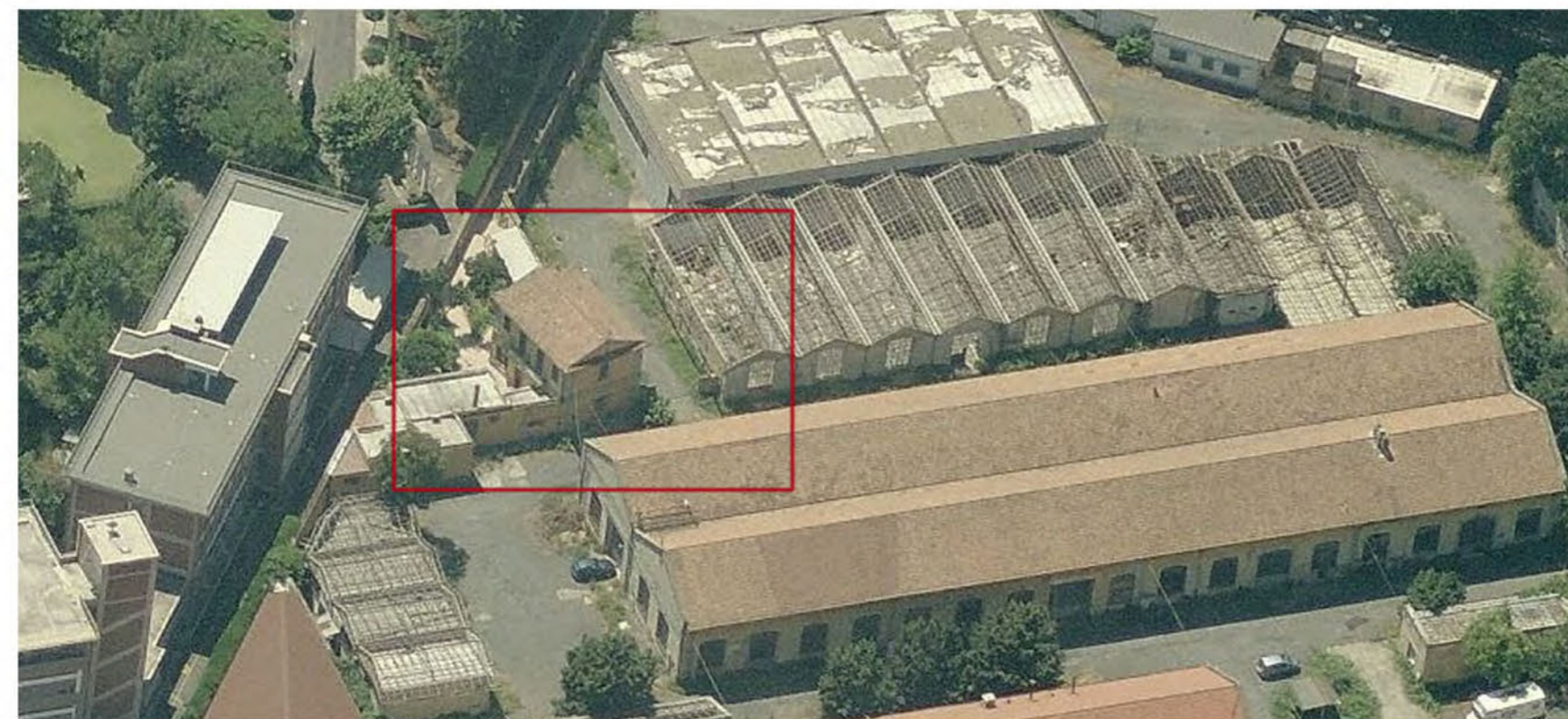
Manufatto persistente, inglobato nell'ampliamento della Fabbrica d'armi Stato attuale. (da Google Map 2011)
