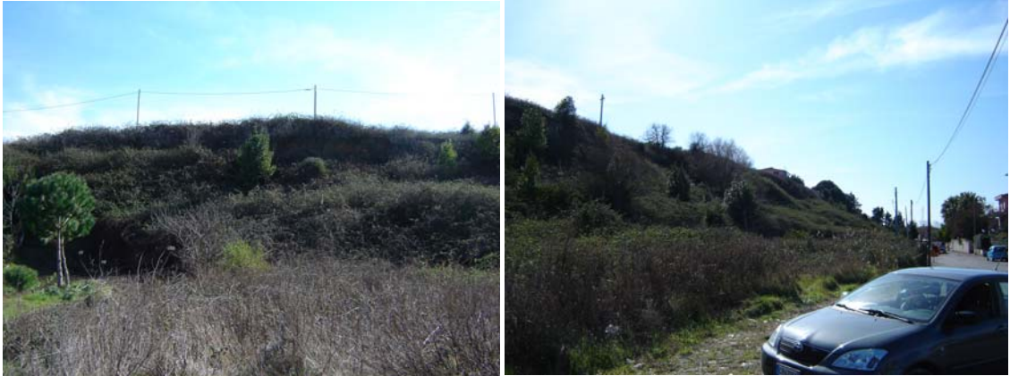
Le foto mostrano fronti di cava dismessi con accumuli di terreni di scoperta di cava instabili
