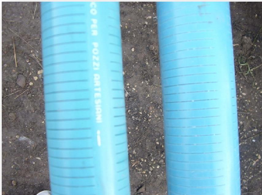
Particolare della tubazione piezometrica installata.
