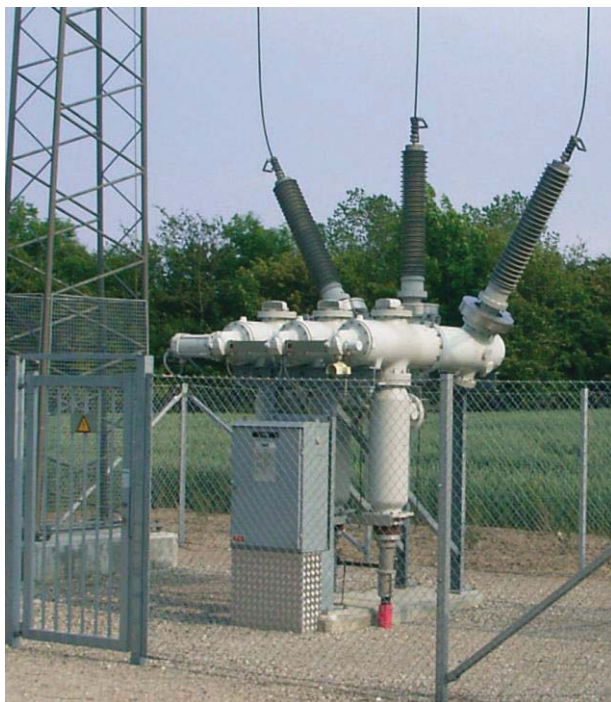
Figura 4.1 – Esempio di stallo di arrivo in cavo con modulo ibrido
