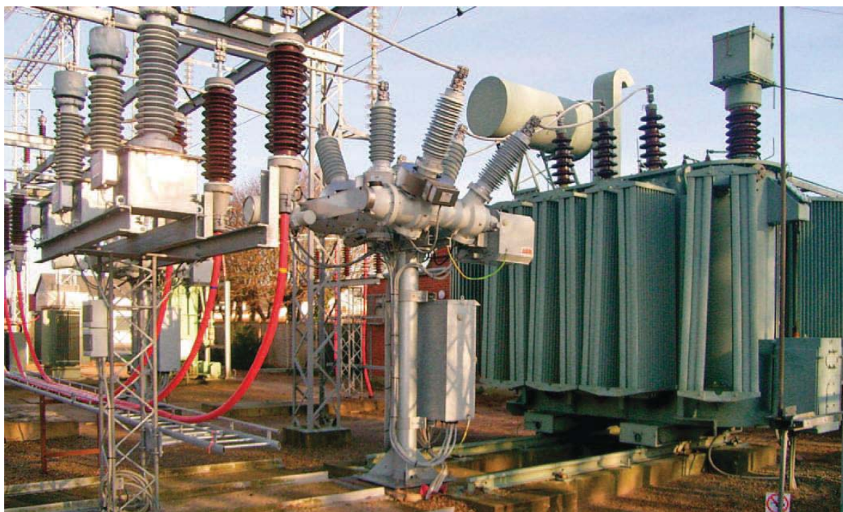
Figura 4.2 – Esempio di stallo TR con modulo ibrido
