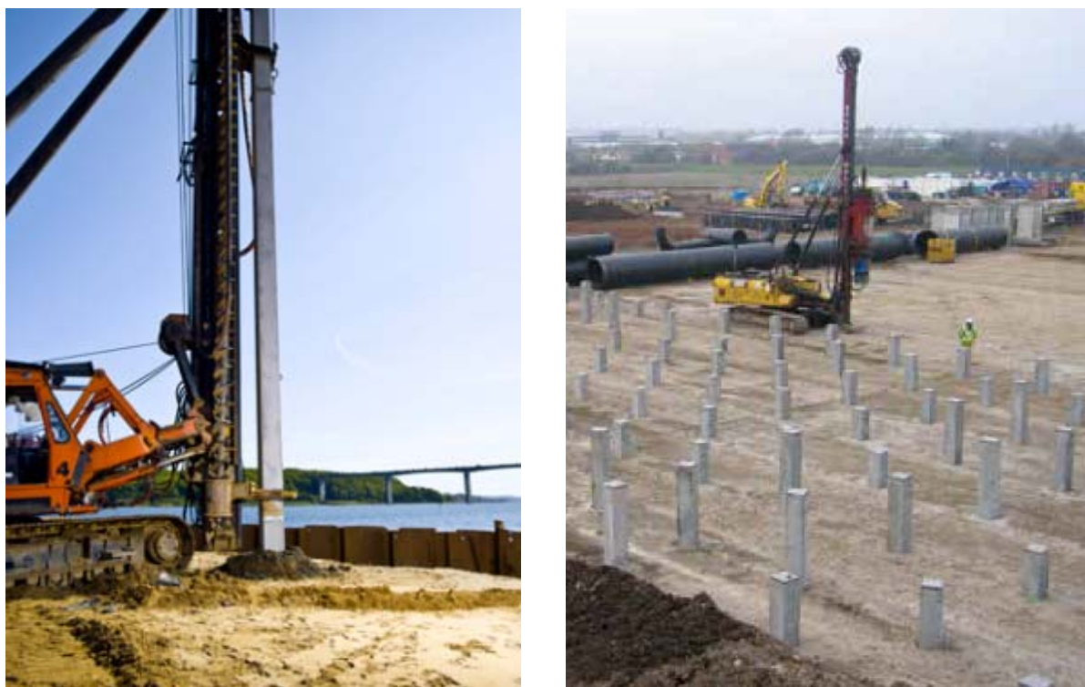
Figura 47 - Installazione per battitura di pali prefabbricati.
