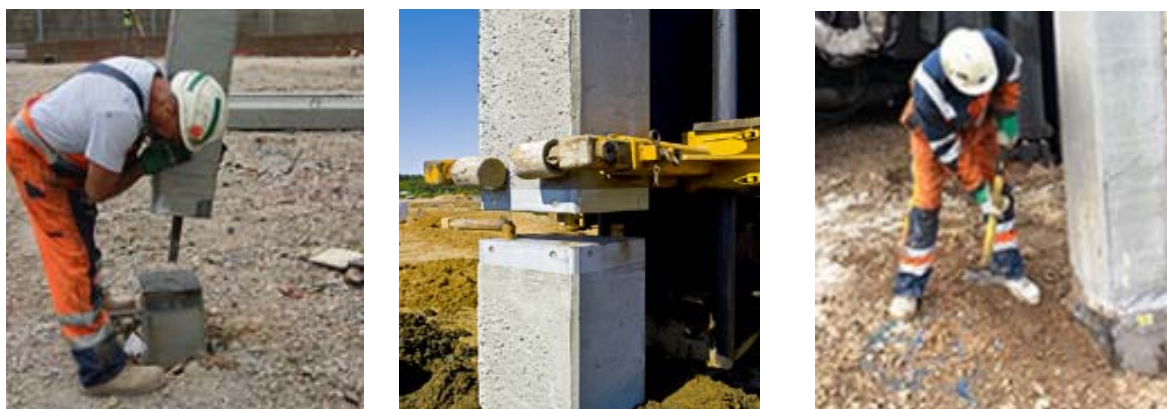
Figura 40: Tipologie di giunto e fasi di installazione.
