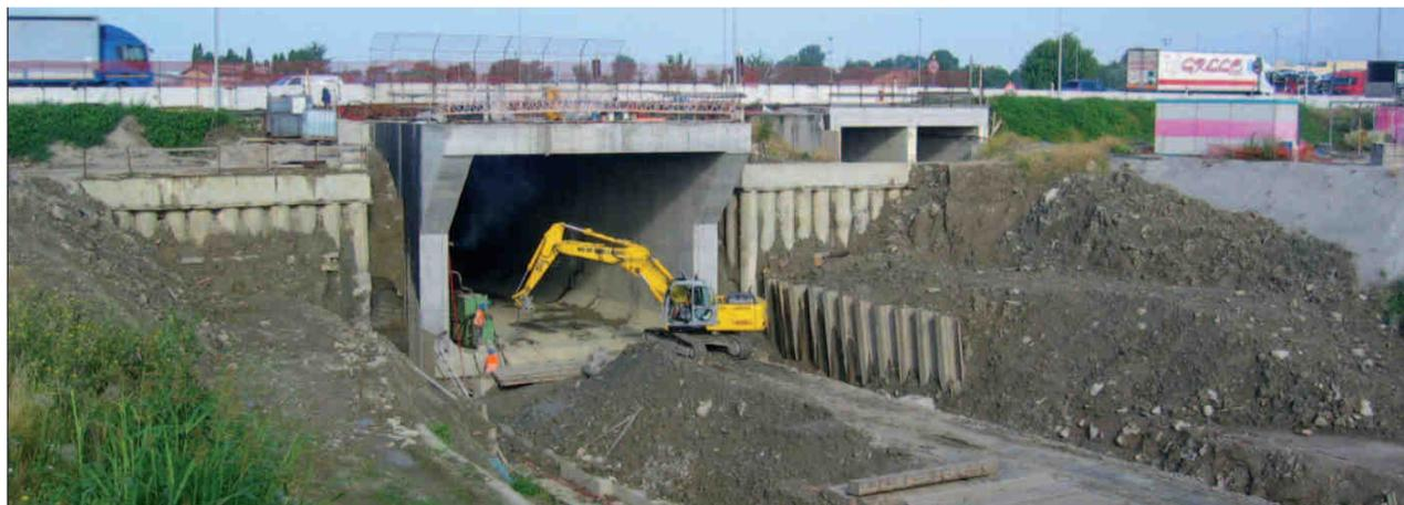
Dal momento che gli attraversamenti in sottovia sono due, il volume complessivo da realizzare al di sotto dell'autostrada con i monoliti di spinta è pari complessivamente a 5.610 mc.
