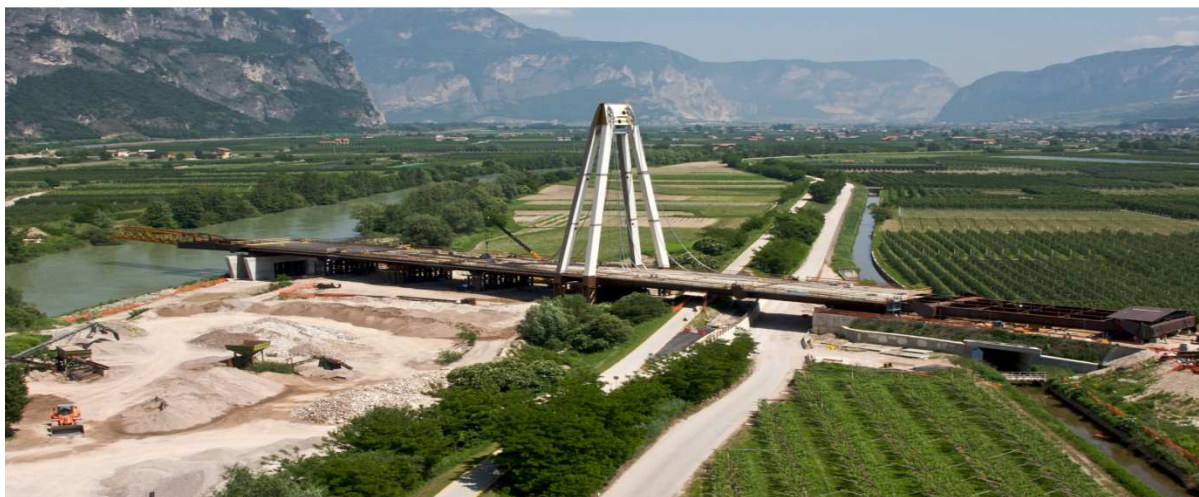
Foto 3 Ponte sul fiume Adige – Fase di varo
