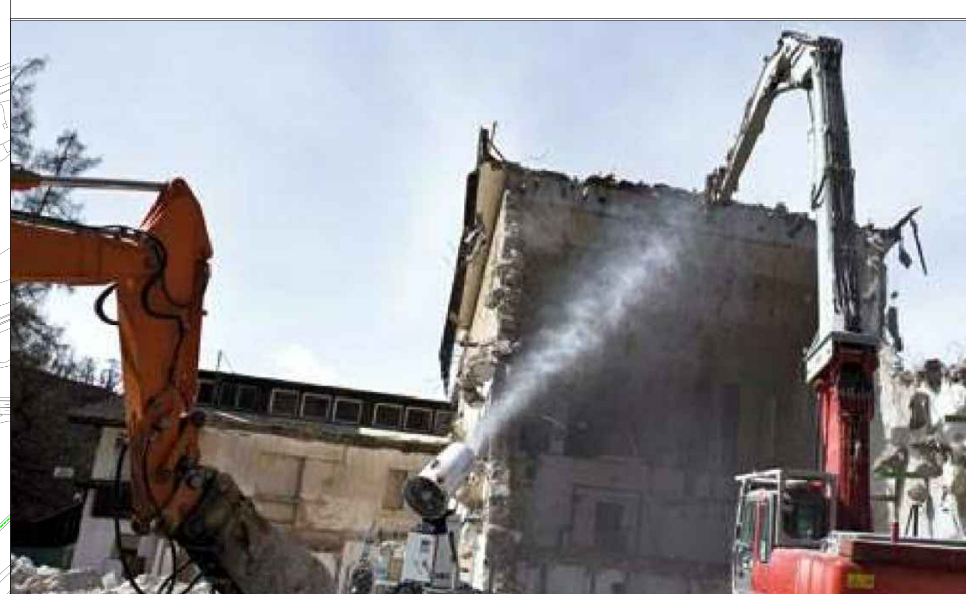
DEMOLIZIONE TRIBUNE CON UTILIZZO PINZA FRANTUMATRICE E PINZA PER CLS
