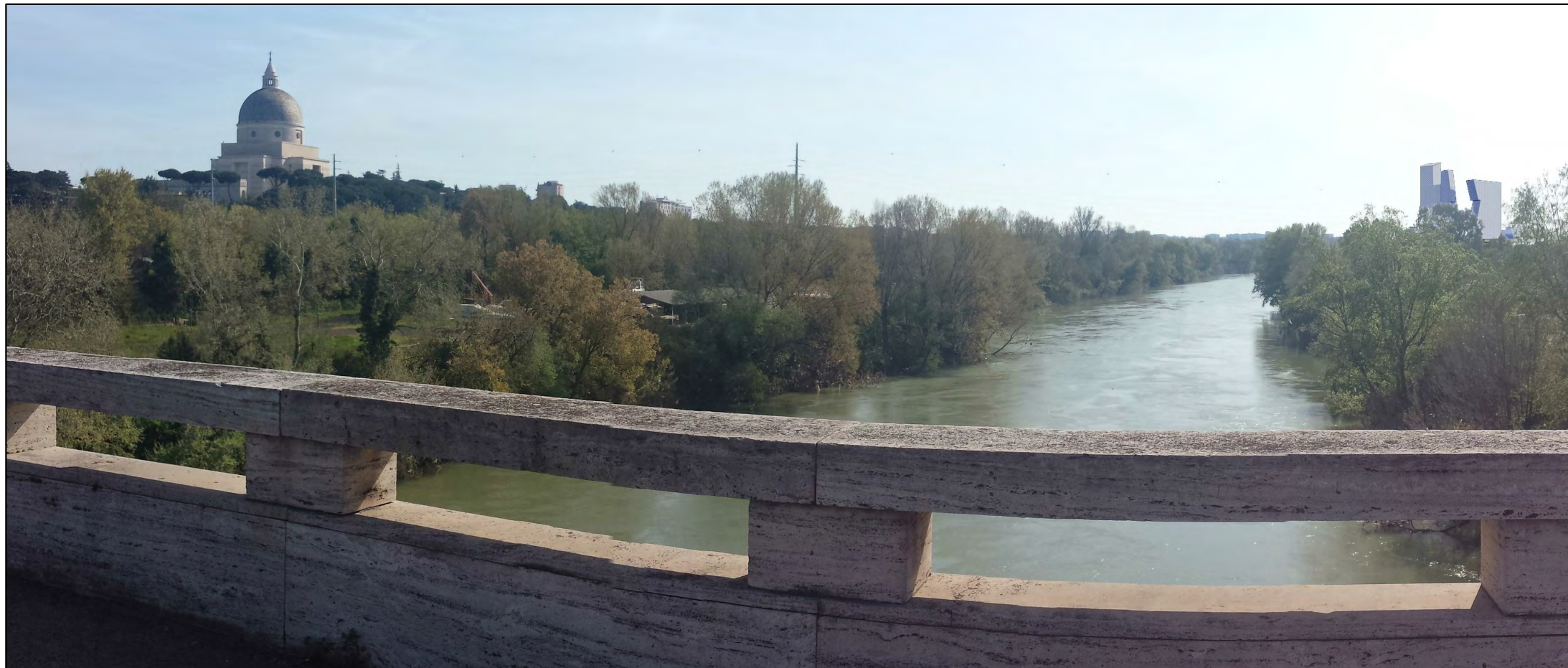
Foto dello stato attuale con inserimento dell'intervento
