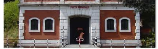
Stato attuale del Forte Trionfale ottobre 2015 B5 Scala 1:1.000
