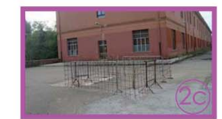
2c - Consolidamento del terreno della zona del cedimento della sede stradale in prossimità del piazzale lato "B"
