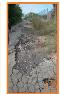
1 c - Lavori di messa in sicurezza del muro di contenimento della sede stradale
