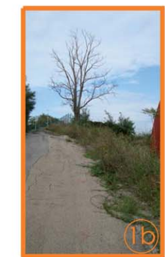
1 b - Sede stradale in prossimità dell'hangar
