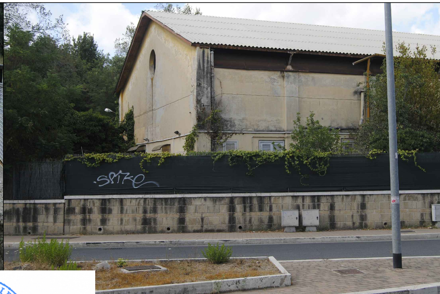
VISTA ESTERNA LATO SUD EST
