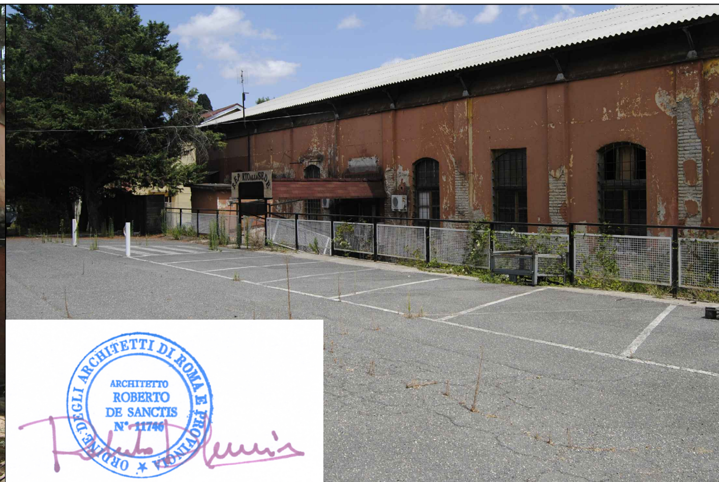
VISTA FRONTE INTERNO INGRESSO
