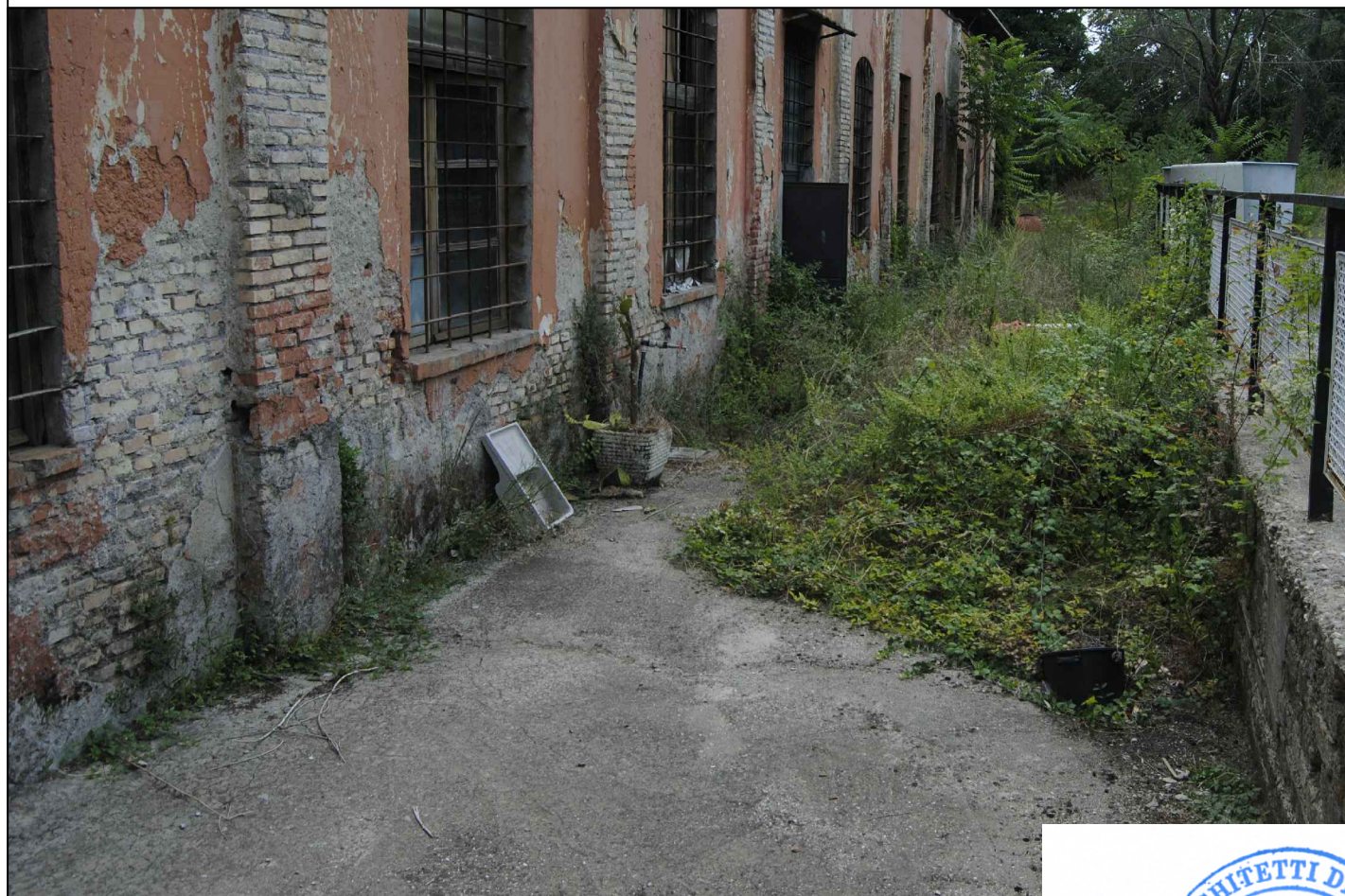
VISTA FRONTE INTERNO LATO OVEST
