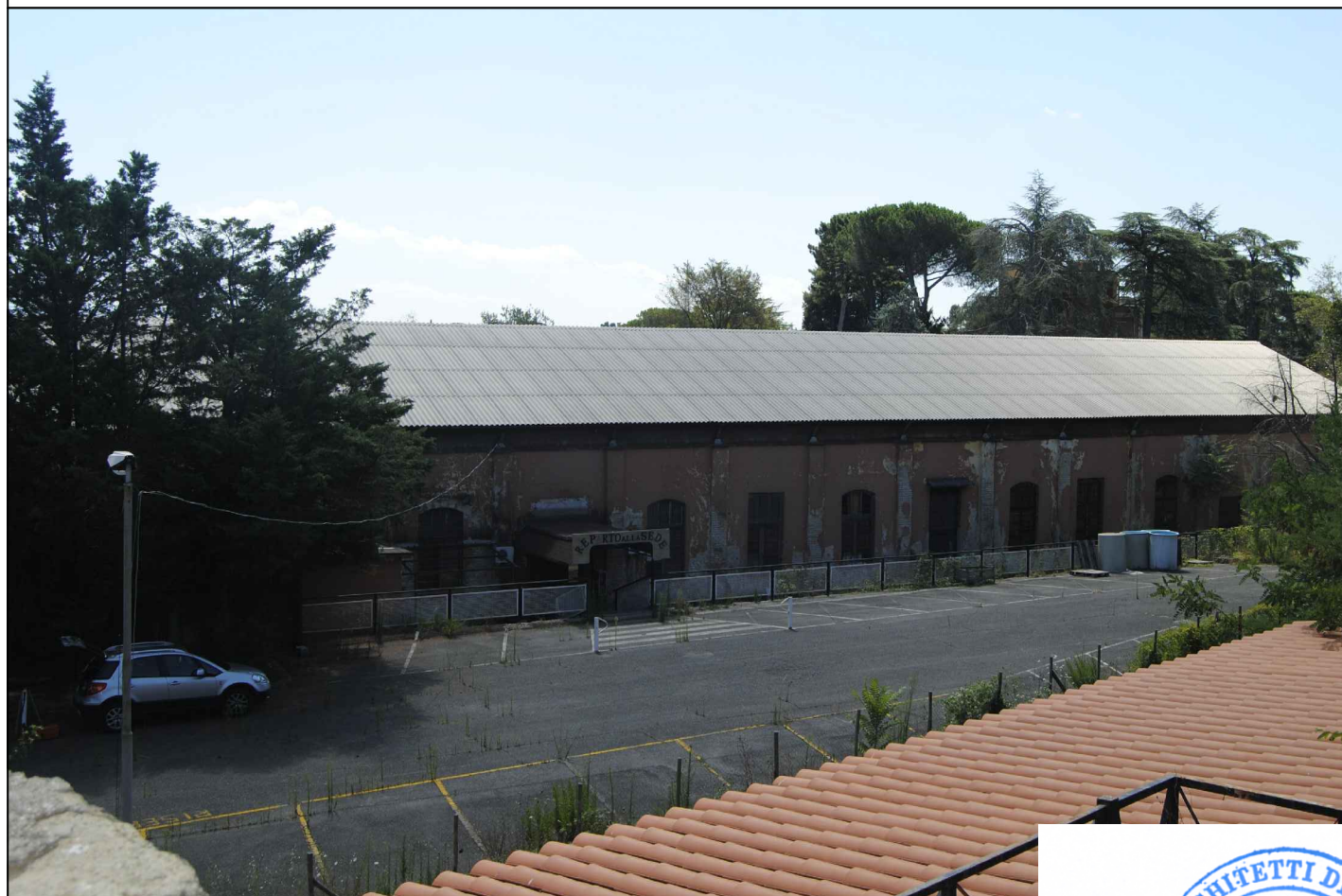
VISTA FRONTE INTERNO LATO OVEST
