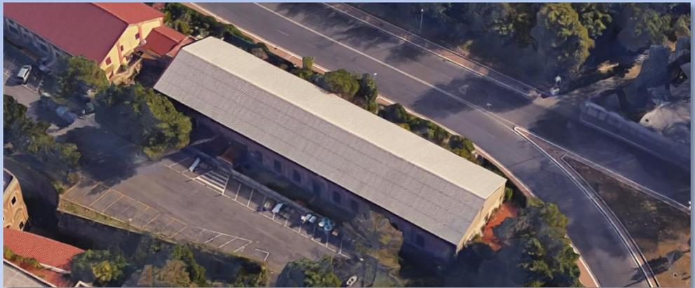
Si tratta di un edificio realizzato in muratura portante, con un piano fuori terra, tetto a doppia falda e copertura in eternit (mq 1.000). E' caratterizzato da una forma in pianta rettangolare, con una superficie di circa 1.000 mq ed un volume di 6,297 mc. Lo stato di conservazione appare buono. L'area è accessibile sia dal piazzale antistante il forte che direttamente da via Trionfale.
