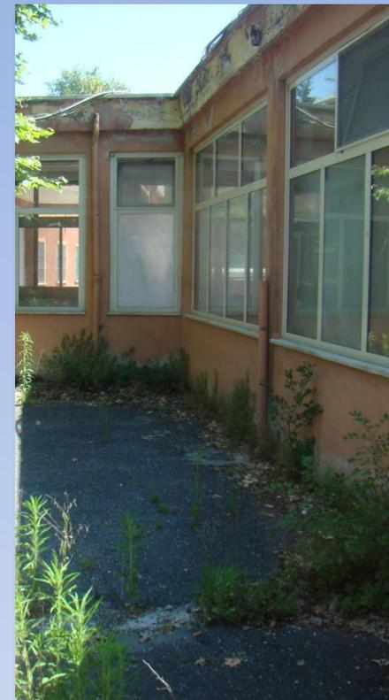
Si tratta di un edificio al livello del ramparo realizzato in muratura portante, con un piano fuori terra e copertura piana. È caratterizzato da una pianta irregolare e da numerosi ambienti di servizio, con una superficie di circa 600 mq ed un volume di circa 3.450 mc. Ospitava le cucine ed è collegato alla mensa da un portico. Attualmente presenta problemi di staticità dovute al cedimento di un muro di contenimento. La sua realizzazione risale agli anni '60.
