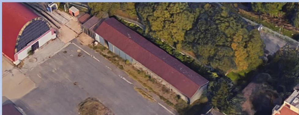
Si tratta di un capannone metallico prefabbricato, con un piano fuori terra, tetto a doppia falda e copertura in lamiera grecata. Ha una forma in pianta rettangolare e lo stato di conservazione appare discreto.
