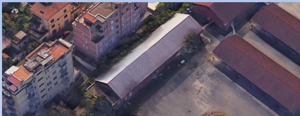
Si tratta di un edificio realizzato in muratura portante con un piano fuori terra, tetto a doppia falda e copertura in lamiera grecata. E' caratterizzato da una forma in pianta pressoché rettangolare. Il fabbricato è inagibile e sono necessari lavori di consolidamento delle fondamenta.
