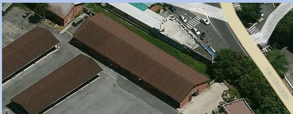
Si tratta di un edificio costruito in muratura portante con un piano fuori terra, tetto a doppia falda e copertura in tegole canadesi. E' caratterizzato da una forma in pianta pressoché rettangolare. Lo stato di conservazione appare sufficiente.
