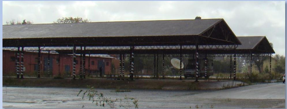
Si tratta di due tettoie con struttura metallica, tetto a doppia falda e coperture in tegole canadesi. Sono caratterizzati da una forma in pianta rettangolare.
