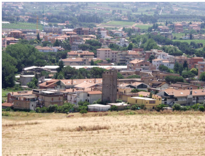
La Torre dei Santi Quattro come si presenta attualmente
