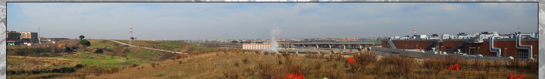
3. foto da ponte pedonale
