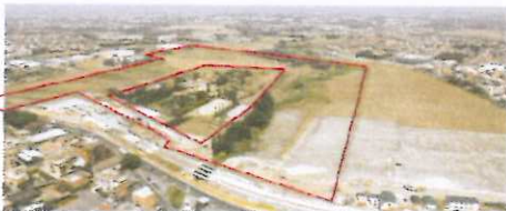
Vista aerea da sud: in primo piano la Via Casilina ed il cantiere per la realizzazione della linea Metro C, sullo sfondo verso sinistra le aree destinate al Parco di Torre Angela, che saranno in continuità con le aree verdi del Progetto Urbanistico. Al centro il Fosso di Tor Tre Teste
