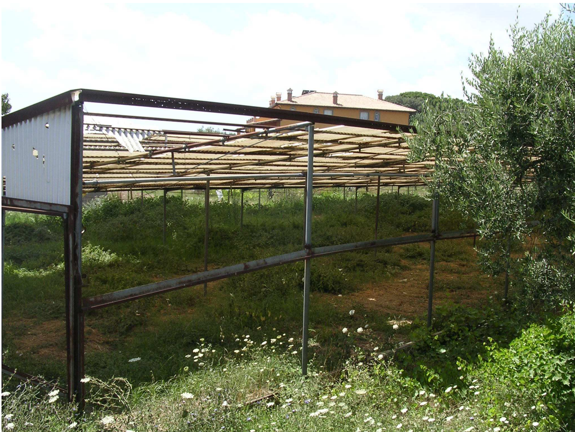
Foto n° 6 Strutture agricole abbandonate
