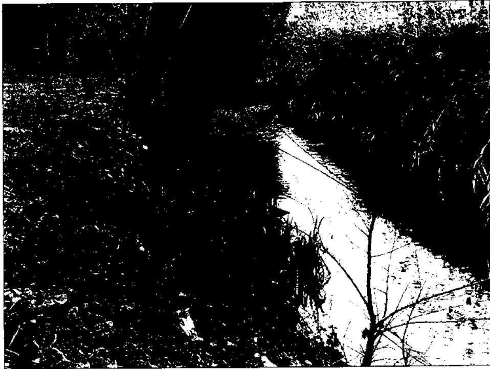
Fig. 7 - Tratto del Fosso Arrone (vista da valle verso monte) interessato in passato da eventi di esondazione causati per dinamica d'alveo e di difficoltà di deflusso a valle nelle fasi di piena, secondo le testimonianze rese allo scrivente.
