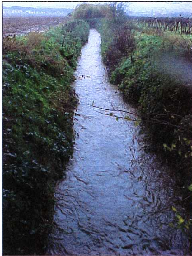
Fig. 1 – Fosso dell'Osa: vista da valle verso monte.
