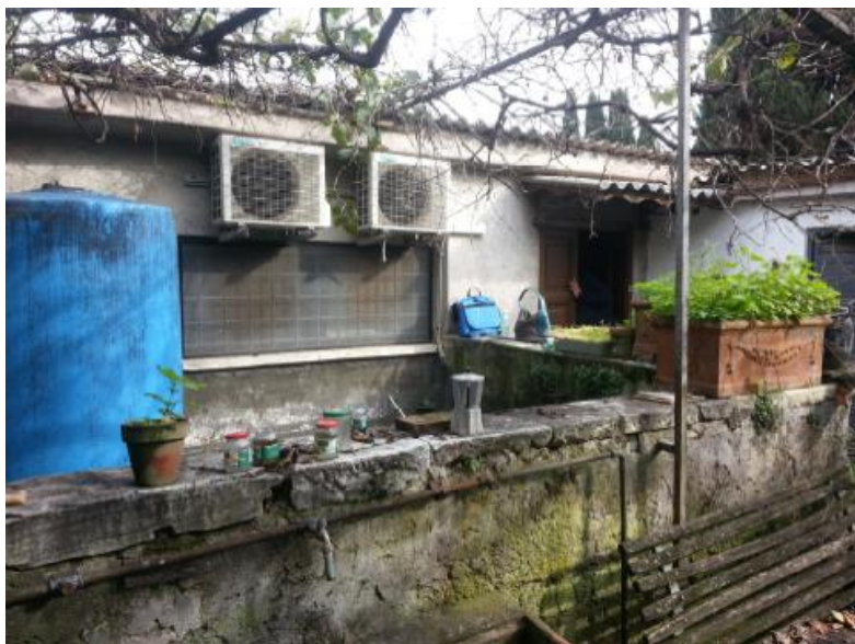
Viste degli edifici da demolire
