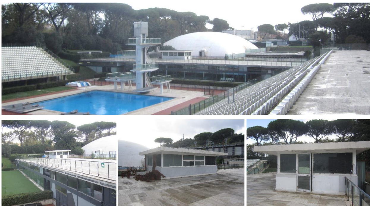
Viste del manufatto da demolire presente sulla terrazza dell'ex ristorante
