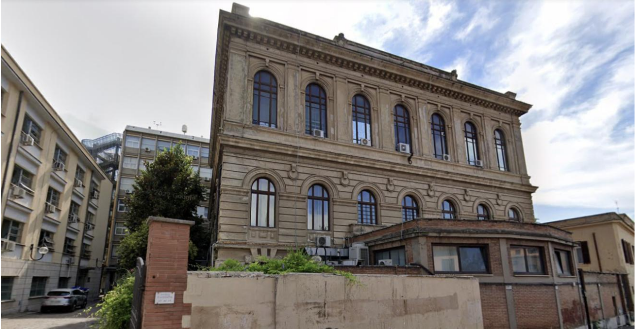
Vista del fronte est dell'edificio da via delle Sette Sale
