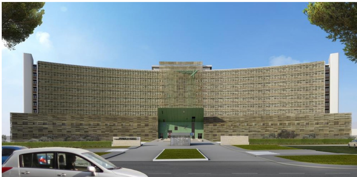
Fig. 1 – Vista del nuovo complesso ospedaliero da via di Grottarossa
