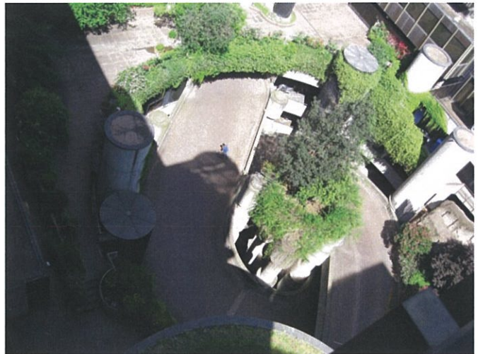
Foto 04 07/05/2014: Vista zenitale corte interna, dettaglio rampe accesso parcheggi
