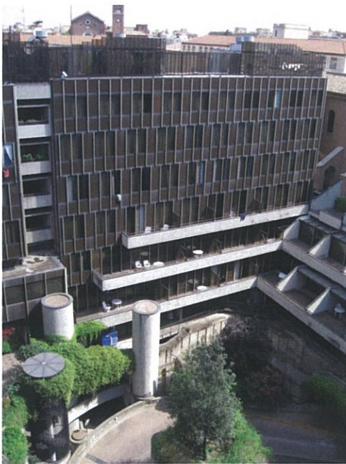
Foto 03 07/05/2014: Vista dal tetto di copertura in direzione NORD-EST
