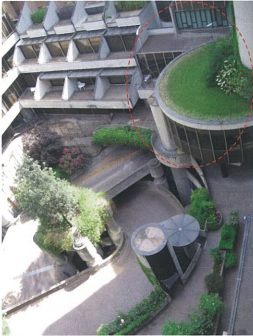
Foto 01 07/05/2014: Vista dal tetto di copertura in direzione SUD-EST
