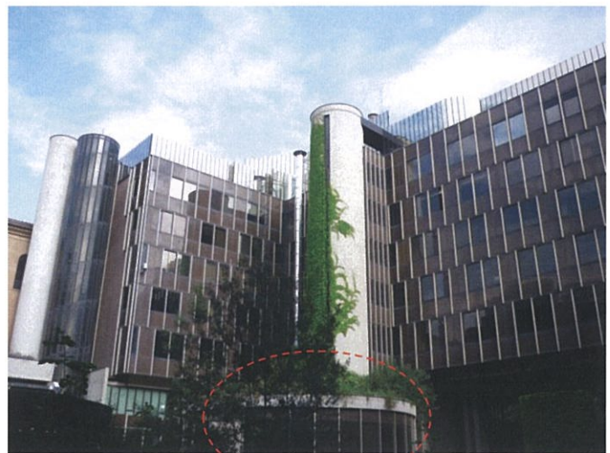
Foto 08 07/05/2014: Vista facciata interna da NORD-OVEST a SUD-EST
