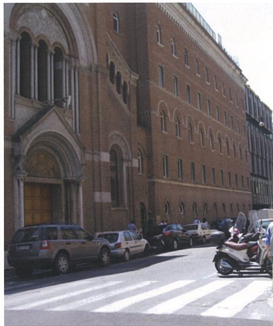
Foto 10 07/05/2014: Vista su Via Sicilia, Ex chiesa e Residence May Fair
