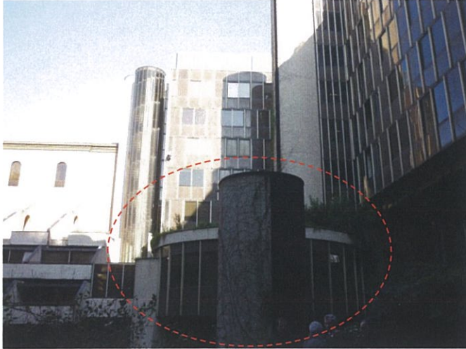
Foto 05 07/05/2014: Vista della corte interna da SUD-OVEST in direzione SUD-EST
