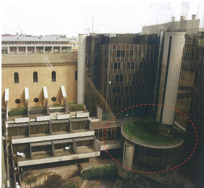
Foto 09 07/05/2014: Vista della corte interna da NORD-OVEST a SUD-EST
