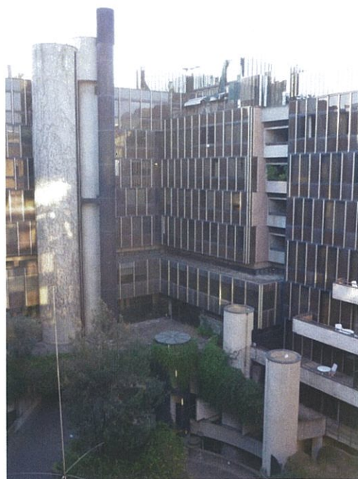
Foto 07 07/05/2014: Vista dall'alto in direzione NORD-OVEST
