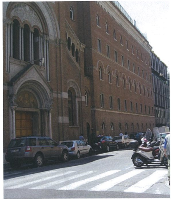
Foto 10 07/05/2014: Vista su Via Sicilia, Ex chiesa e Residence May Fair
