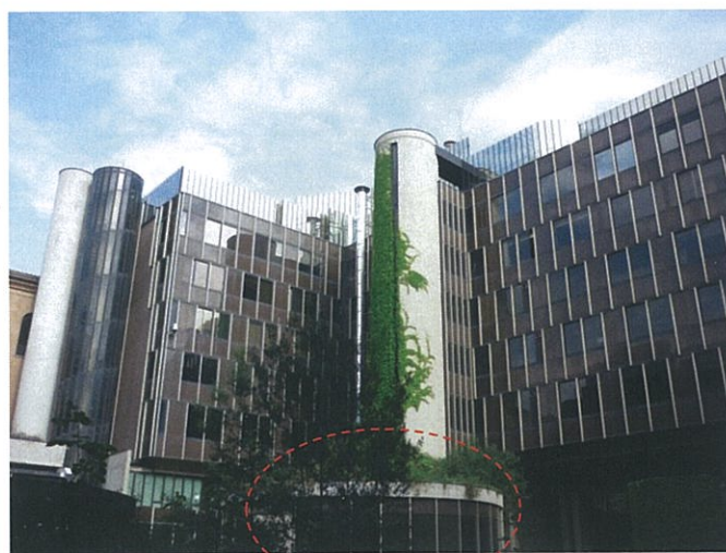
Foto 08 07/05/2014: Vista facciata interna da NORD-OVEST a SUD-EST
