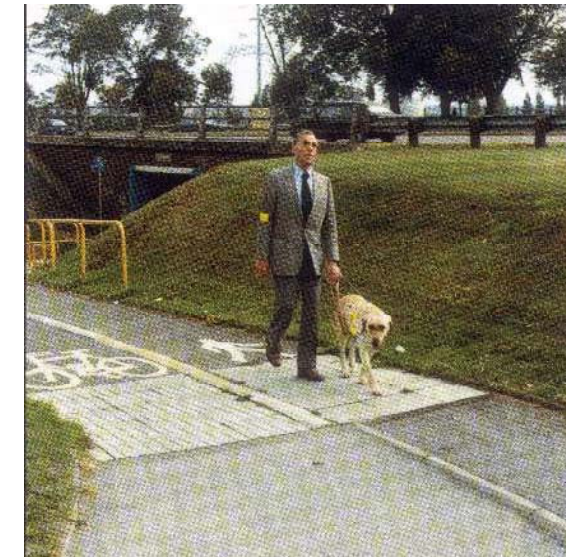
Figura 12 – Esempio di percorso pedonale e ciclabile fuori della sede stradale con trattamento della pavimentazione per i non vedenti (Inghilterra)
