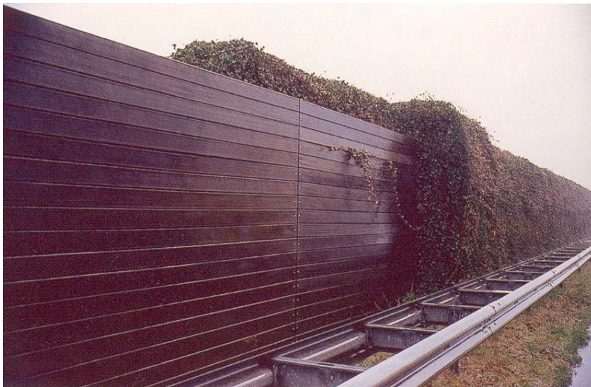
Figura 40 – Esempio di barriera antirumore in legno unita ad una bio-barriera
